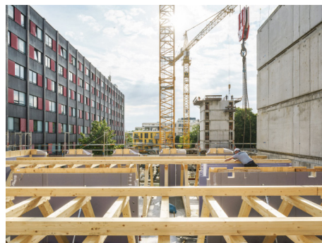
SebastianSchelsDSC05266.jpg Unterkonstruktion für Decke Foto: Sebastian Schels
