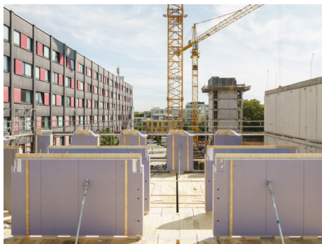
SebastianSchelsDSC00712.jpg Baustelle Holzwände Foto: Sebastian Schels
