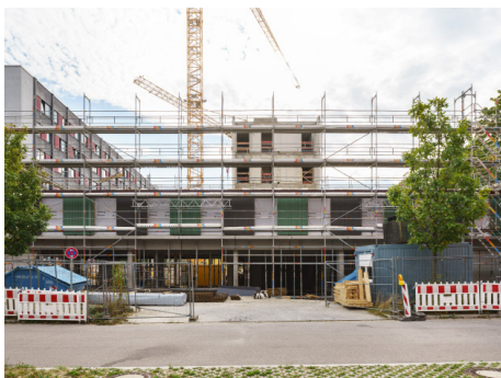
SebastianSchelsDSC05940.jpg Einfahrt Baustelle Foto: Sebastian Schels
