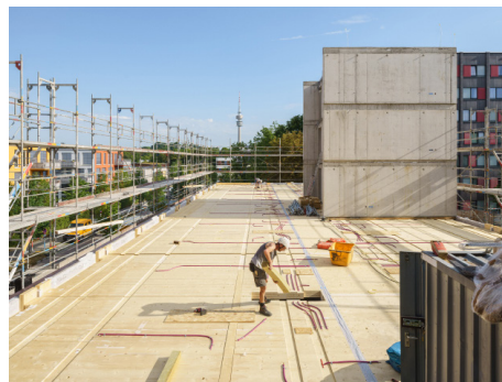
SebastianSchelsDSC5926.jpg Baustelle Blick Olympiaturm Foto: Sebastian Schels
