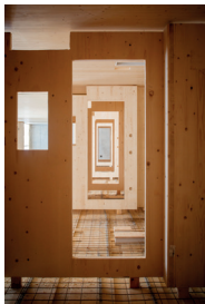
Ulrike Myrzik J3A4645.jpg Ausschnitt Baustelle Foto: Ulrike Myrzik
