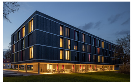
Florian Holzherr 0025.jpeg Ansicht Fahrradparkplatz Foto: Florian Holzherr
