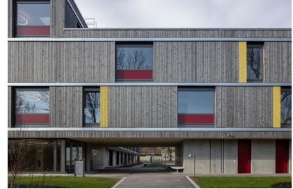
Florian Holzherr 0022.jpeg Ansicht Fassade Eingangsbereich Foto: Florian Holzherr
