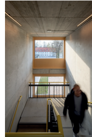
Florian Holzherr 0002.jpeg Treppenhaus Foto: Florian Holzherr
